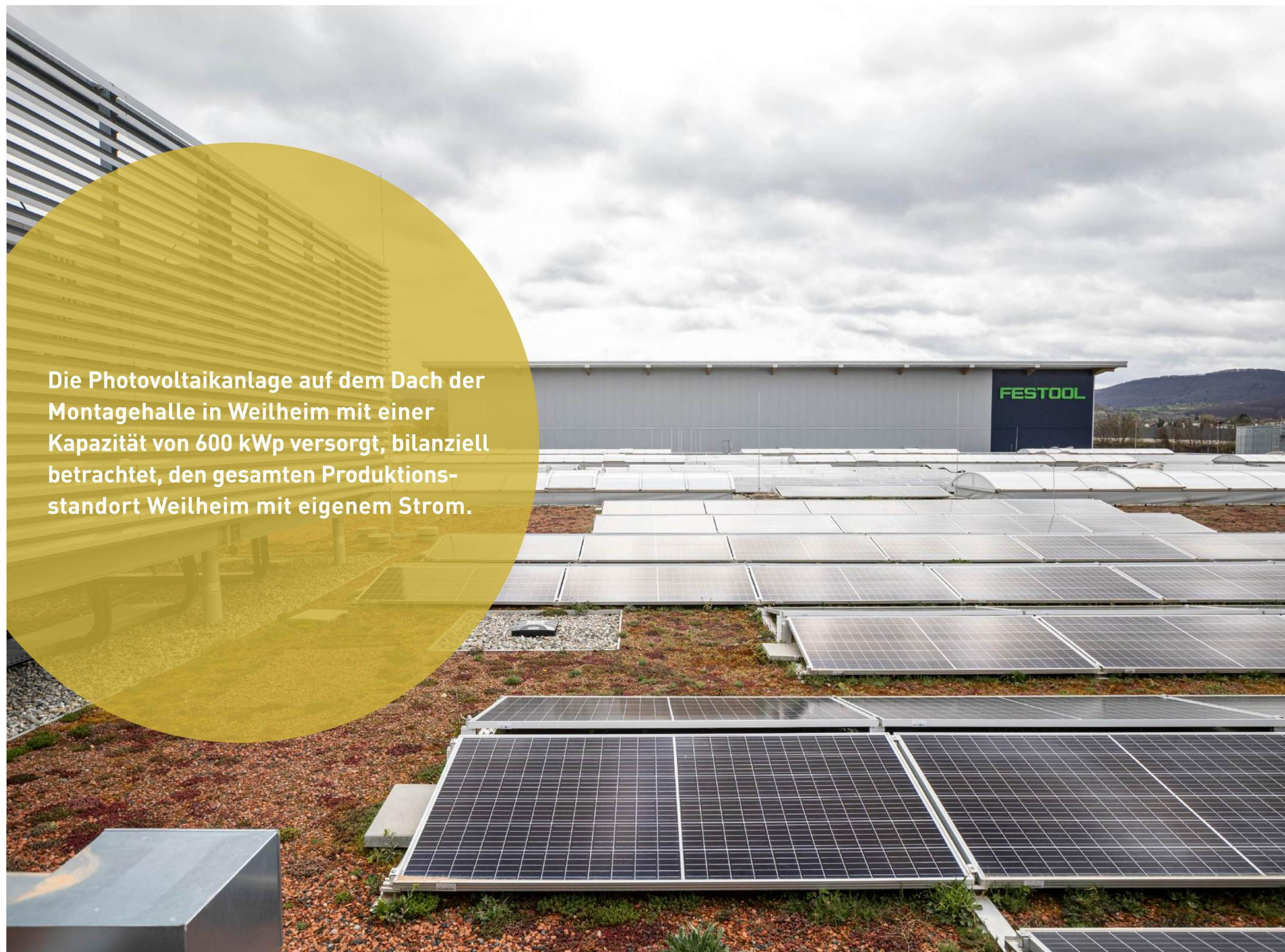
Die Photovoltaikanlage auf dem Dach der Montagehalle in Weilheim mit einer Kapazität von 600 kWp versorgt, bilanziell betrachtet, den gesamten Produktionsstandort Weilheim mit eigenem Strom.
