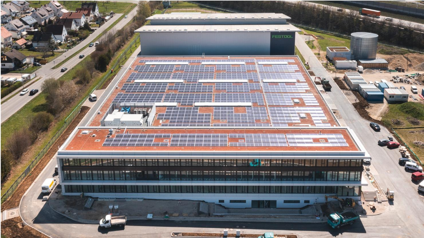
Der Neubau unseres Montagegebäudes in Weilheim/Teck entspricht modernsten energetischen Gebäudestandards. Auf dem Dach der Montagehalle befindet sich eine Photovoltaik-Anlage mit einer Leistung von bis zu 600 kWp. Sie produziert den Großteil des benötigten Stromes selbst und trägt zur Erreichung einer nachweisbaren, positiven Energiebilanz des Gebäudes bei.
