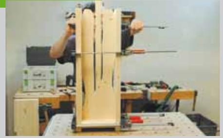
Verspannen Sie alles mit Zwingen und stellen Sie das Untergestell auf dem Boden auf. Zwischen den Blättern werden Abstandsklötze verwendet, um ein Zusammendrücken beim Anziehen der Zwingen zu verhindern. Legen Sie die Platte zunächst einmal „trocken“ auf und kontrollieren Sie, ob alles passt.
