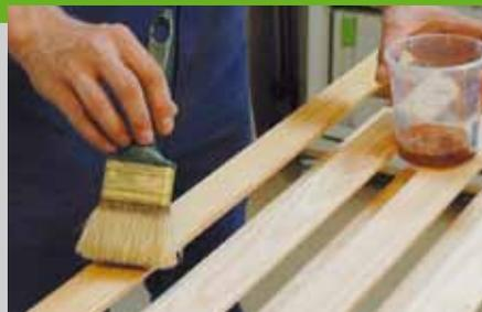
Als Abstandshalter zwischen den Leisten dient eine 40 mm breite Leiste. Nachdem alle Bleistiftstriche weg geschliffen sind, können Sie die Oberfläche mit einer wasserfesten Lasur oder einem Öl behandeln.
