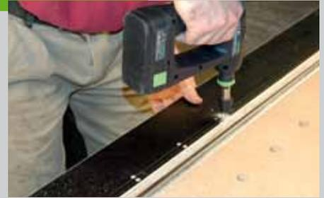
denen Sie ca. 10 mm versetzt zueinander die Löcher (D= 4,5 mm) für die Netzbefestigung bohren. Zeichnen Sie sich unten an der Innenseite der Rückplatte die Position der Aufdopplung an. Bohren Sie in die Leiste vier Löcher (D= 4,5 mm).
