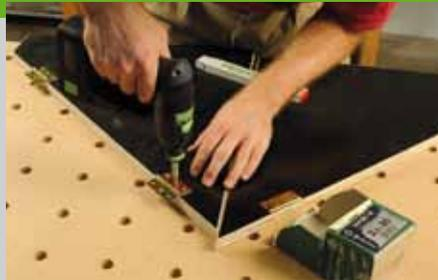
Dreiecken auf der jeweiligen Innenseite zwei Scharniere fest. Stellen Sie die Rückplatte auf die Bodenplatte und markieren Sie die Position der Scharnierlöcher mit dem Vorstecher. Dann schrauben Sie die Scharniere an der Bodenplatte fest. Anschließend klappen
