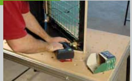
Sie die Platten auf und legen zunächst ein Seitenteil dazwischen. Richten Sie das Seitenteil mit der Vorderkante des Bodens bündig aus und schrauben Sie die beiden Scharniere an der Rückplatte fest. Mit dem zweiten Seitenteil wird entsprechend verfahren.
