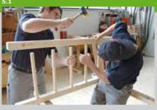
5. Die Seitenteile der Leiter (Pos. 6) werden auf das angegebene Maß abgesägt. Zeichnen Sie die Positionen der Löcher auf den Seiten an und bohren Sie diese mit einem 30 mm Bohrer, Längen Sie die Sprossen auf das passende Maß ab und entgraten Sie die Schnittkanten. Nachdem alle Kanten abgerundet sind, wird die Leiter
