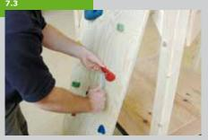
Die Klettergriffe werden mit Einschlagmuffen an der Wand befestigt. Dafür wird zunächst ein 12 mm Loch in das Brett gebohrt und dann von hinten die Muffe eingeschlagen. Der Griff wird dann mit einer Gewindeschraube von vorne in der Muffe befestigt. Zusätzlich sollten Sie die Schraube noch mit Kleber im Gewinde gegen selbstständiges herausdrehen sichern.
