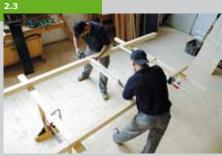
Achten Sie darauf, die Schraubenlöcher versetzt zueinander zu bohren, damit die Schrauben in den Ecken nicht zusammenstoßen. Spannen Sie die Wände mit Zwingen zusammen. Mit einem Gummihammer werden die Querbalken eventuell noch einmal ausgerichtet. Wenn dann alles passt, wird es miteinander verschraubt.
