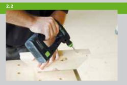
Zwei der späteren vier Wände werden auf Böcken zusammen geschraubt (siehe Schraubentipp). Legen Sie dazu jeweils einen langen und einen kurzen Balken auf Arbeitsböcke und zeichnen Sie die Positionen der Querbalken (Pos. 3) ein. Bohren Sie die Löcher (6 + 8 mm) für die Schrauben in den Pfosten und den Knacken vor.
