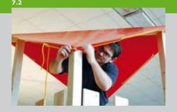
Plane, die an den vier Ecken mit Ösen in den kurzen Eckpfosten und im Firstbalken eingedrehten Schrauben eingehängt wird. Schneiden Sie die Kletterwand (Pos.12) auf das angegebene Maß ab und runden Sie die Kanten. Die Kletterwand wird mit Scharnieren am Gesell befestigt. Dadurch kann sie zum Rasenmähen nach oben geklappt werden.
