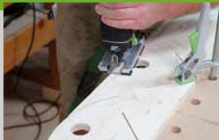
Die beiden 45 Grad Schnitte werden mit einer Tischkreissäge oder mit der Stichsäge gesägt. Die Oberkante mit der Stichsäge und einem Kurvensägeblatt ausgesägt. Unten in die Absperungen wird mit einer Lochsäge ein 50 mm Loch gesägt, in das später ein Wasserrohr eingesteckt werden kann.
