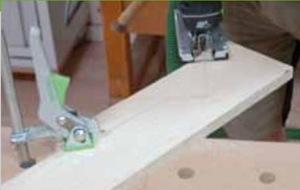
4. Nach dem Trocknen werden unter die Stützen noch die Füße (Pos. 3) und oben die Abdeckungen (Pos. 4) festgeschraubt. Die Form der Auflagen für die Rinnen (Pos. 5) aufzeichnen und mit einer Stichsäge aussägen. Sie sollten, wenn sie in die Stützen eingesteckt sind, maximal ein bis zwei Millimeter Luft zwischen den Rundstäben haben. Auch hier die Kanten wieder abrunden.
