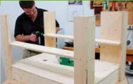
5. Kaufen Sie zuerst den Kübel und rechnen Sie sich die Breiten der Stützbretter (Pos. 19) so aus, dass Sie unter den Rand des Kübels passen. Verschrauben Sie die Stützbretter mit den Tischbeinen und schieben Sie zur Kontrolle den Kübel ein. Bevor Sie die Pumpe befestigen, müssen die Einzelteile des Wasserspiels gestrichen
