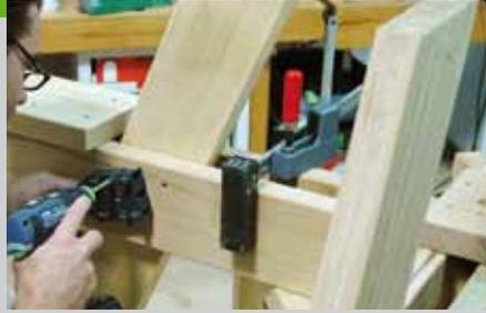
Platte (Pos. 13) geklebt und festgeschraubt. Diese steifen das Gestell zusätzlich aus und dienen als Aufnahme für den Sonnenschirm. Stecken Sie die Beine in das Gestell und schieben Sie sie in die richtige Position. Mit einer Zwinde werden sie mit dem Gestell verklemmt. Schlossschrauben (M8 x 120) verbinden Beine und Gestell. Die 8 mm Löcher müssen möglichst gerade durch die
