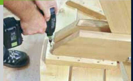
drücken, können Sie einen Systainer (SYS 4) darunter stellen. Richten Sie die Sitzplatten aus, bohren Sie die Löcher und schrauben Sie die Sitze von unten fest. Stellen Sie den Tisch auf und kontrollieren Sie noch einmal alle Kanten und Flächen auf rauhe oder scharfkantige Stellen und schleifen Sie gegebenenfalls noch einmal nach.
