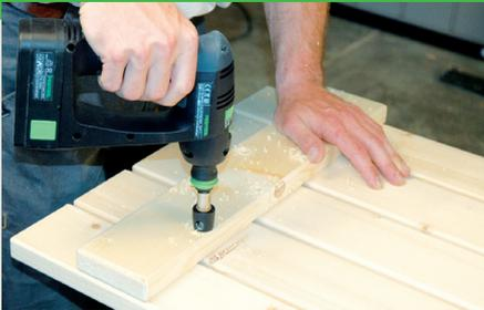
2. Bohren Sie die Schraubenlöcher mit einem Akkuschauber. Wenn möglich, einen Bohrer mit Versenker benutzen, der das Loch gleich dem Schraubenkopf anpasst. Bei Schraubarbeiten ist es ratsam, die Rutschkupplung (Drehmomenteinstellung) am Akkuschauber einzustellen, sonst ist
