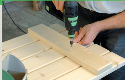
schnell eine Schraube überdreht oder zu tief im Holz versenkt. Legen Sie die Bretter für die Tischplatte auf Ihren Arbeitstisch, mit der Unterseite nach oben. Zwischen die einzelnen Brettern werden nach Wunsch Abstandsklötze (ca. 8 mm) gelegt.
