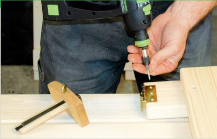
3. Schrauben Sie die Scharniere an den oberen Enden der Beine an. Es ist wichtig, dass die Rollen der Scharniere ca. 3 mm über die Oberkante der Beine hinausragen. Seitlich werden die Scharniere auf den Brettern vermittelt. Die Untergestelle mit den Scharnieren nacheinander auf die Querbretter stellen.
