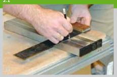
2. Markieren Sie die einzelnen Gestellteile mit dem Schreinerdreieck. Dadurch können Sie am Schluss problemlos jedes Teil genau seiner Position zuordnen. In die Edelstahlbeine werden 10 mm Löcher für die Dübel gebohrt. Dazu werden die Dübellöcher angezeichnet und vorgekörnt. Zunächst bohren Sie mit einem 5 mm Bohrer vor, danach wird das eigentliche Loch mit einem
