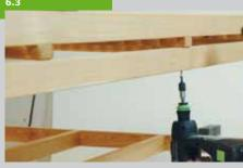
(Spax 4 x 70). Zerlegen Sie nun die Bank in Gestell und Sitzfläche und schleifen Sie raue Stellen mit einem Exzenterschleifer nach. Kleben Sie vor der Oberflächenbehandlung die Edelstahlrohre mit Kreppband ab, das erspart unnötige Reinigungsarbeiten.
