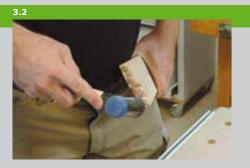
Bohren Sie die Löcher in das Querholz der Streben. Die Bohrungen für die Verbindungen zwischen Längs- und Querstreben (Pos. 5 u. 6) werden auf die gleiche Art hergestellt. Runden oder fasen Sie die Holzkanten (Kantenfräse oder Handschleifklotz). Das Klebeharz wird im Verhältnis 2:1 (Harz:Härter) angemischt, allerdings zunächst nur so viel, dass Sie eine der beiden Bankseiten
