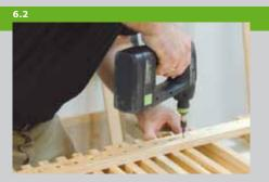
Es ist hilfreich, wenn Sie einen zweiten Akkuschrauber oder eine Bohrmaschine benutzen. Wenn die Sitzfläche verschraubt ist, wird sie auf das Gestell aufgelegt und ausgerichtet. Zeichnen Sie am Gestell die Positionen der Löcher für die Befestigungsschrauben an und bohren Sie diese. Verschrauben Sie Gestell und Sitzfläche miteinander
