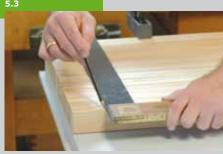
Die anderen Leisten werden an der ersten angelegt und ausgerichtet. Zeichnen Sie mit einem Winkel an, wo die Auflageleisten festgeschraubt werden.
