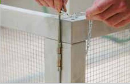
6. Vor der Montage des Drahtgitters sollten auch alle Rahmen gestrichen werden. Um das Freigehege später einfach zusammensetzen zu können, werden Kulissenscharniere eingesetzt. Bei diesen lässt sich der Stift in der Drehachse entfernen und das Gehege kann zerlegt und verstaut werden.
