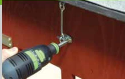
Schneiden Sie dann das Drahtgitter so zu, dass es ca. 20 mm innen über die Ausschnitte übersteht, die Scharniere müssen dabei ausgespart werden. Schneiden Sie Dachpappe für die gesamte Dachfläche zu und nageln Sie diese fest. Die Scharniere werden am Dach befestigt und das Dach wird auf dem Stall festgeschraubt. An Türe und Dach werden die Verschlüsse befestigt.
