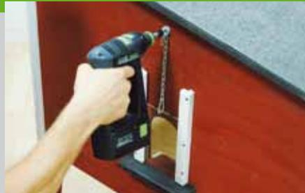
dem Balkon auf und kann nicht von Krallen nach oben gehebelt werden. Schrauben Sie die Führungen und den Balkon an und testen Sie, ob sich die Tür leicht öffnen und schließen lässt. Die Nullposition der Türe wird durch eine Kette festgelegt. Mit einer zweiten Schraube oberhalb der Kette kann die Tür in geöffneten Zustand eingehängt
