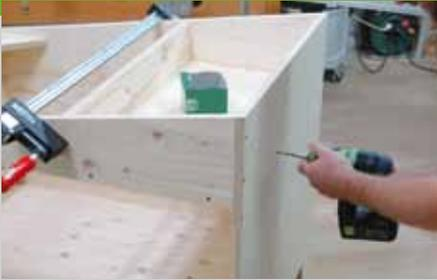
3. Oben in den Stall werden zwei Bretter (Pos. 7 + 8) geschraubt. Diese ergeben gemeinsam ein Fach, in dem Futter trocken gelagert werden kann. Zeichnen Sie die Fenster und die Türe an. Bohren Sie in den Ecken jeweils ein Loch (mind. 8 mm), damit Sie mit der Stichsäge die Ausschnitte sägen können. Damit die Türe bündig am Stall anliegt, werden mit der Stichsäge zwei
