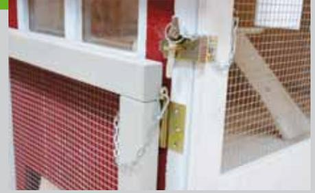
von innen auf den Rahmen festgenagelt. Um das Freigehege auch am Stall zu befestigen, wird anstatt des einen kurzen Rahmens der Stall selbst mit dem Freigehege verbunden. Sie können zusätzlich noch einen Rahmen mit Gitter, als Abdeckung und Schutz vor Greifvögeln, über das Freigehege legen.
