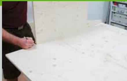
müssen Sie auf der Führungsschiene unbedingt Rückschlagsicherungen festspannen, da sonst die Säge durch den Rückschlag beim Eintauchen aus der Führung springen kann. Spannen Sie die Schiene zusätzlich noch auf dem Werkstück fest. Um das genaue Höhenmaß zu ermitteln, stellen Sie die Seiten auf die Giebelwand (Pos. 2) auf und zeichnen Sie die Oberkante an.
