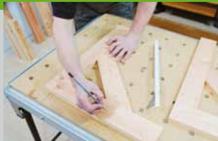
Zur leichteren Orientierung werden die Teile mit einem Schreinerdreieck und Ziffern gekennzeichnet (Infos zum Schreinerdreieck unter [www.kurswerkstatt.de](http://www.kurswerkstatt.de)). Die Einzelteile der Tischplatte (Pos. 5 + 6 + 7) auch zusammenlegen und mit einem Dreieck kennzeichnen.
