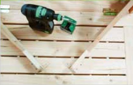
6. Es wird für jede Abstützung mit einem Anschlagklotz (Pos. 11) ein Endpunkt festgelegt. Ein kleiner Keil (Pos. 12) auf der Innenseite verhindert einerseits das unbeabsichtigte zurückschieben der Abstützungen mit dem Knie, andererseits erleichtert er das Ausklappen. In die Abdeckplatte wird ein Loch gebohrt, durch das die Stange
