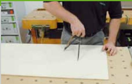
1. Mit einem Zirkel oder einer an einen Bleistift gebundenen Schnur werden die einzelnen Kreise (Pos. 3 +4) und Halbkreise (Pos. 1 +2) auf die Sperrholzplatten aufgezeichnet. Der Mittelpunkt wird jeweils markiert. Bei den Kreisen wird mit einem Winkel durch
