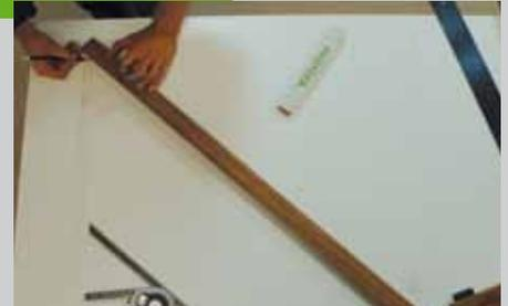
aus diesem Aufriss heraus messen. Die Länge der Beine, die Position der Querleisten und den Drehpunkt können Sie auch aus dem Aufriss übertragen. Die Beine des Untergestells (Pos. 10) werden auf der Tischkreissäge schräg abgeschnitten.
