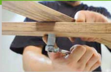
Muttern werden Beilagscheiben gelegt. Die Muttern werden mit einer Ratsche oder einem Schlüssel soweit angezogen bis der Schraubenkopf bündig auf dem Holz aufliegt. Legen Sie das Gestell seitlich auf den Anriss und stellen Sie benötigte Breite ein. Befestigen Sie auf einer Seite der Kette einen Karabiner und messen die Kettenlänge, die Sie
