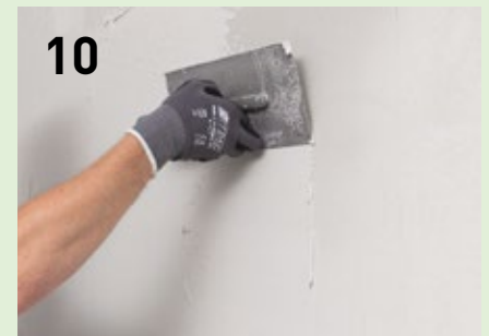
10 Feinputz IQ Fill anrühren und verspachteln. Im erhärteten Zustand ist der Putz diffusionsoffen und wasserbeständig.
