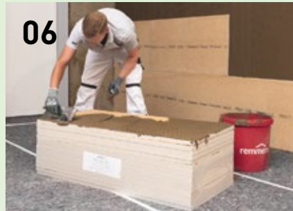
06 Zur vollflächigen Verklebung der Dämmplatten wird PP Fix mittels Zahnkelle auf Wand und Platte appliziert.
