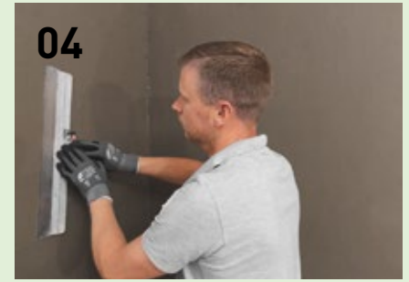
04 Untergrund mit Klebemörtel PP Fix und einem breiten Flächenspachtel egalisieren (bis 8 mm).
