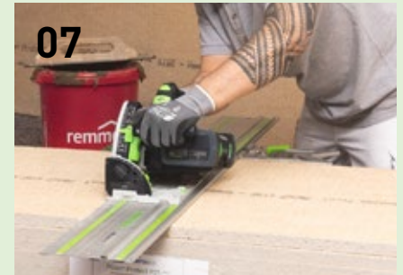
07 Wandanschluss-Platten mit Festool TSC 55 und Führungsschiene zuschneiden. Überstehende Stöße bei Bedarf mit ETS EC 150/5 beischiefen.
