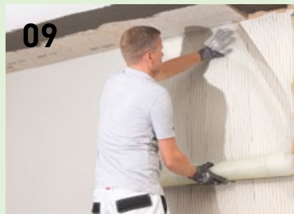
09 Armierungsgewebe mit dem Glätter in senkrechten Bahnen faltenfrei und überlappend in den Armierungsmörtel einarbeiten.
