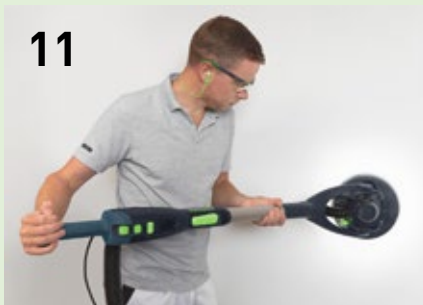
11 Verspachtelte Wand mit dem Festool Langhalschleifer PLANEX LHS 2 225 und Schleifmittel Granat Net P120-P180 schleifen.
