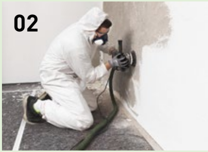
02 Schadhafte Putzstellen und Altbeschichtungen mit der Renovierungsfräse oder dem Sanierungsschleifer abtragen.
