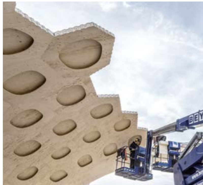
→ Die Hohlkassettensegmente wurden teilweise vormontiert und ohne Unterkonstruktionen oder Stützgerüste vor Ort zusammengefügt.
