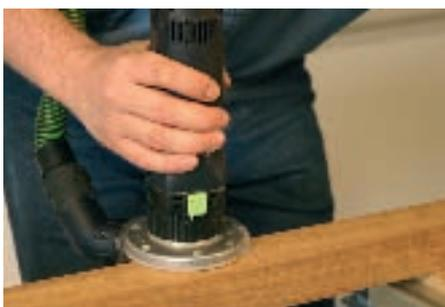
8. Runden Sie alle Kanten mit einer Kantenfräse oder einer Oberfräse (Radius 3 mm). Die Rundungen mit einem Handschleifklotz schleifen. Abschließend alle Flächen noch einmal mit dem Exzentrerschleifer schleifen (Körnung P 180).
