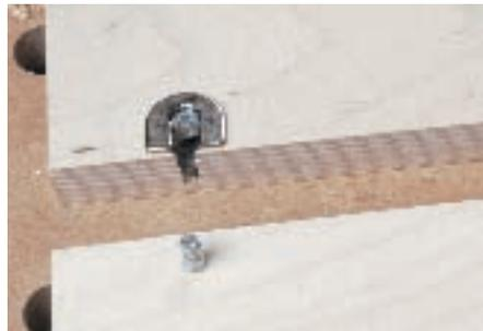
5. Jetzt kann der Beschlag in die Bohrungen eingeschlagen werden. Dazu verwende ich einen Schonhammer, Sie können auch einen Metallhammer nehmen. Legen Sie dann aber ein Klötzchen dazwischen, um den Beschlag nicht zu beschädigen. Achten Sie auch darauf, dass der Beschlag nicht verdreht eingeschlagen wird, Sie bekommen ihn anschließend nur noch mit Mühe heraus. Wollen Sie ihr Werkstück noch mit einer Holzoberflächenbehandlung versehen, sollten Sie die Beschläge noch nicht einsetzen.
