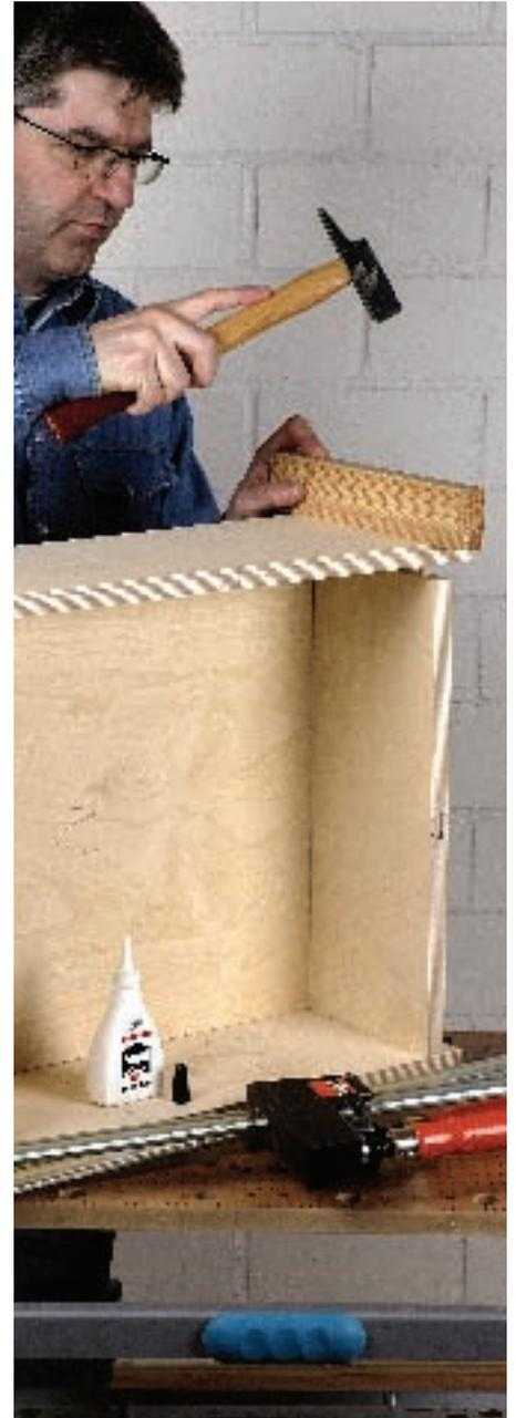
16. Bevor Sie den Schrank verleimen, sollten Sie zunächst einmal alle Teile ohne Leim auf Passgenauigkeit überprüfen. Erst wenn alles passt und genügend Zwingen vorhanden sind wird das Ganze verleimt.
