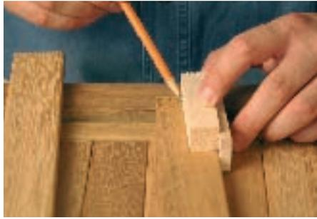
Fräse runden und die Löcher zum Festschrauben bohren ( $D = 3,5 \text{ mm}$ : am besten Senkbohrer mit Tiefenanschlag benutzen). Mit einem Handschleifklotz die Schmalflächen und die Rundungen
