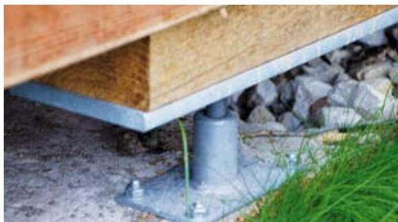
Ein verstellbarer Fuß ist auf einem Fundament befestigt. Er sorgt dafür, dass der Steg den nötigen Bodenabstand hat. So kann unter der Holzkonstruktion die Luft zirkulieren und Feuchtigkeit trocknet schnell wieder ab.
