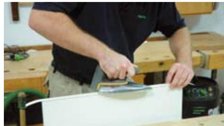
**2.** Bügeln Sie auf die jeweiligen Kanten mit einem alten Bügeleisen eine Schmelzkleberkante auf. Diese erhält man passend in entsprechendem Dekor. Das Bügeleisen darf bei dieser Arbeit nicht auf höchster Stufe eingestellt sein, da gerade weiße Kanten dann „anbrennen“ und unansehnlich braun werden. Drücken Sie die Kante unmittelbar nach dem Aufbügeln mit einem Holzklötz fest an, denn Sie ist warm und will sich aufstellen.
