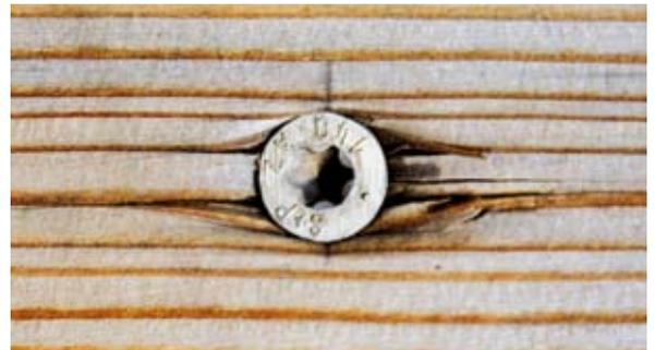
Korrosionsbeständige Schrauben sind für harzhaltiges Lärchenholz geeignet.
