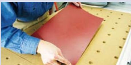
**2.** Legen Sie die zu verpressenden Teile aufeinander, indem Sie an einer Ecke beginnen und das HPL dann an einer Kante der MDF-Platte herunter lassen. Flächen, die bereits Kontakt miteinander hatten, lassen sich in der Regel nicht mehr ablösen.
