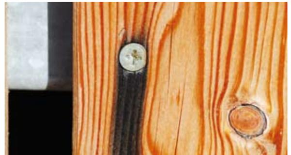
Hier wurden in einem harzhaltigen Holz Schrauben verarbeitet, die nicht korrosionsbeständig sind. Die Schrauben haben mit dem Harz reagiert und es kommt zu den schwarzen Streifen.
