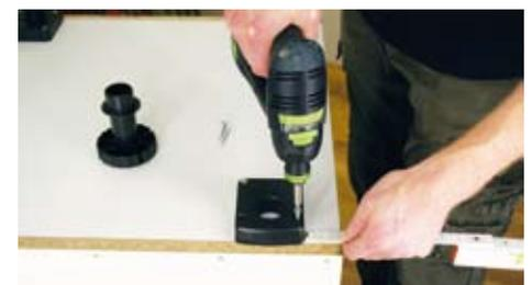
**6.** Montieren Sie im letzten Arbeitsgang, wenn es sich um einen Unterschränk handelt, die Gleiter für die Sockelverstellfüße unter den Schrank. Diese sollten von der Vorderkante etwas eingerückt werden, damit der Sockel später zurückspringt und man nicht beim Arbeiten in der Küche ständig davor tritt.
