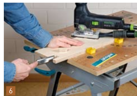
6 Den Rest mit der Stichsäge vorsichtig aussägen. Letzte Einpassarbeiten am besten mit einem scharfen Stechbeitel vornehmen. Der Schlitz sollte möglichst genau zur Rahmenstärke passen.
