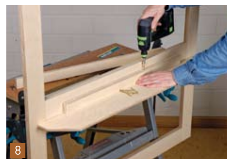
8 Der Boden für die Theke wird mit zwei Holzleisten zusätzlich stabilisiert. Dazu Boden in den Rahmen einlegen, beide Leisten fest gegen Rahmen drücken und am Boden festschrauben.
