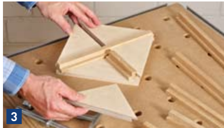
3 Zum Schluss den langen Gleiter wieder umstecken und mit einem kurzen Gleiter das letzte ...
