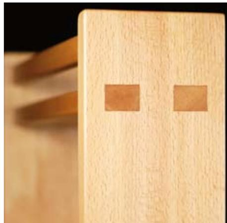
Durchgestemmte Zapfen machen die klassische Massivholz-Konstruktion sichtbar.
