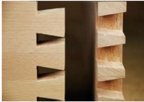
Bei der Herstellung der offenen Schwalbenschwanz-Verbindungen kamen ausschließlich Handwerkzeuge zum Einsatz.
