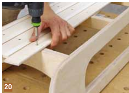
20 gen und mit Kantenrundungen versehen. Die fertigen Leisten werden dann mit versenkten Edelstahlschrauben auf den Querträgern befestigt. Abschließend erhalten die Kufenunterseiten noch
