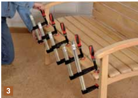
3 Das vorderste Sitzbrett wird ganz zum Schluss mit mehreren Zwingen auf die angeschrägte Querzarge geleimt und nicht verschraubt.
