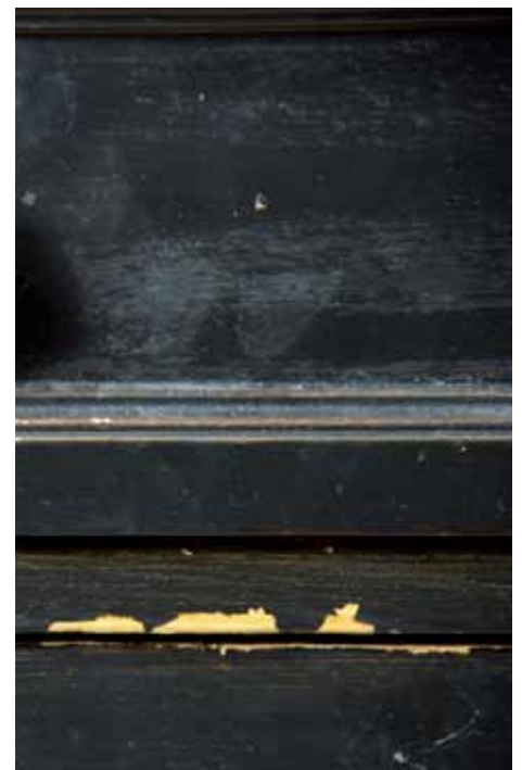
Lackschäden erfordern ein Abschleifen der alten Oberfläche
