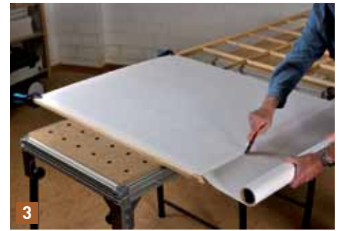
3 Rollen Sie das Papier quer über die vier Felder aus und schneiden Sie es mit einem scharfen Cuttermesser am Rahmenende ab. Richten Sie es dann genau an der unteren Sprosse aus ...
