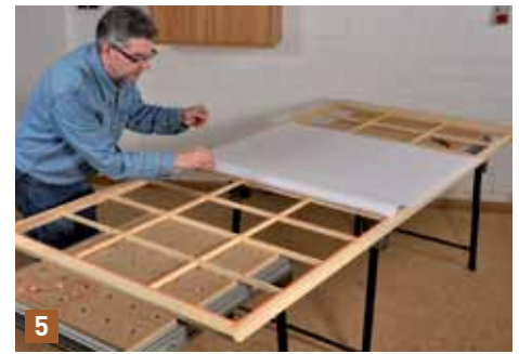
5 Kleben Sie das Papier zunächst nur an der unteren Quersprosse fest. Schlagen Sie es dann um, und entfernen Sie jetzt auch die Schutzschicht von den restlichen Klebebändern.
