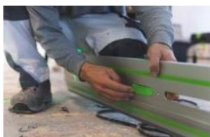
Bevor die verlängerte Führungsschiene von 5,7 Meter an der Decke fixiert wird, befestigt Chef Noah Stelzle die Klebepads (s. Tipp 2) an der erweiterten Führungsschiene FS und überprüft, ob die Pads richtig sitzen. *(Bild 6)*
