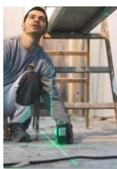
Um absolut sicher zu sein, dass die zu sägende Linie gerade in der langen Flucht von 13 Metern ist, richtet Noah Stelzle mit Hilfe eines Kreuzlinienlasers die Linie an die Decke aus.
