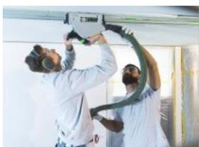
Jetzt geht es um die zweite Linie für das Profilelement. Das Stelzle Team hilft zusammen, um auch den zweiten, parallelen Schnitt präzise mit der Akku-Tauchsäge TSC 55 zu erhalten. *(Bild 12)*
