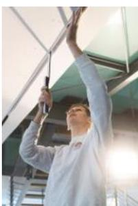
Abschließend kontrolliert Raphael Berg mittels des Profilelements, ob alles richtig zugesägt ist und sieht: alles passt ideal. Im Anschluss können die Maler die komplette Decke beschichten und nach der Trocknung die Profileiste einbauen für die LED Lichtbänder. *(Bild 16)*
