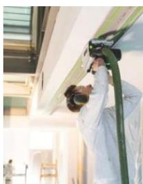
Nun folgt ein weiterer, entscheidender Moment: Raphael Berg sägt die erste Linie mit der Akku-Tauchsäge TSC 55 KEB und dem Kreissägeblatt Wood Universal (HW 160x1,8x20 W28) entlang der extra langen Laserlinie exakt gerade. (s. Tipp 3) *(Bild 10)*
