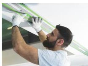
Stelzle Mitarbeiter Muharrem Kuyucu befestigt zunächst die Führungsschiene mit den neuen Klebepads an den Untergrund. *(Bild 8)*
