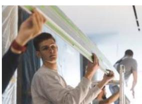
Bei diesem Arbeitsschritt bedarf es wieder mehrere Hände: Das Stelzle Team entfernt die extra lange Führungsschiene vorsichtig und stellt sie sicher ab. *(Bild 14)*
